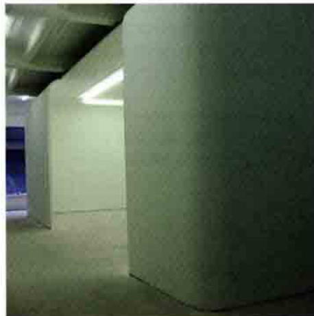
LA GALERIE: VUE DE L'ESPACE PENDANT LES TRAVAUX D'AMÉNAGEMENT, FÉVRIER 2005
